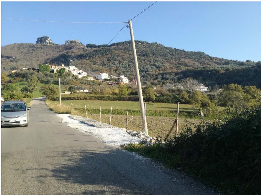
Figura 32 - Creep superficiale con interventi di stabilizzazione in località Masseria Pomice
