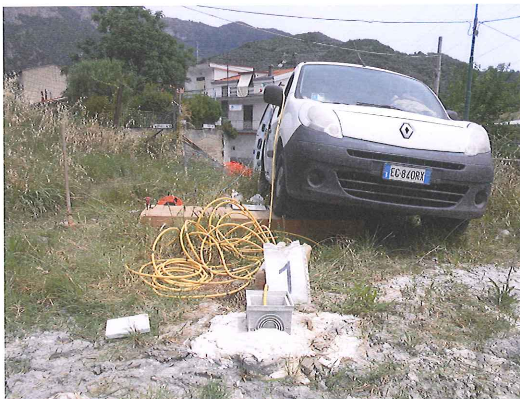
Foto n° 1 – Postazione sondaggio sismico in foro denominato DH.1
